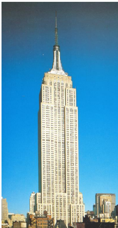
Рис.61. Эмпайр-стейт-билдинг. 1931, США. Светлые полосы на фасаде здания – из нержавеющей стали; высота здания вместе с телевизионной башней равна 499м
